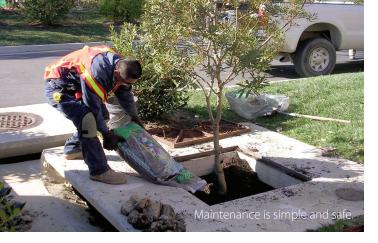
Filterra<sup>™</sup> Stormwater Bioretention Filtration System
